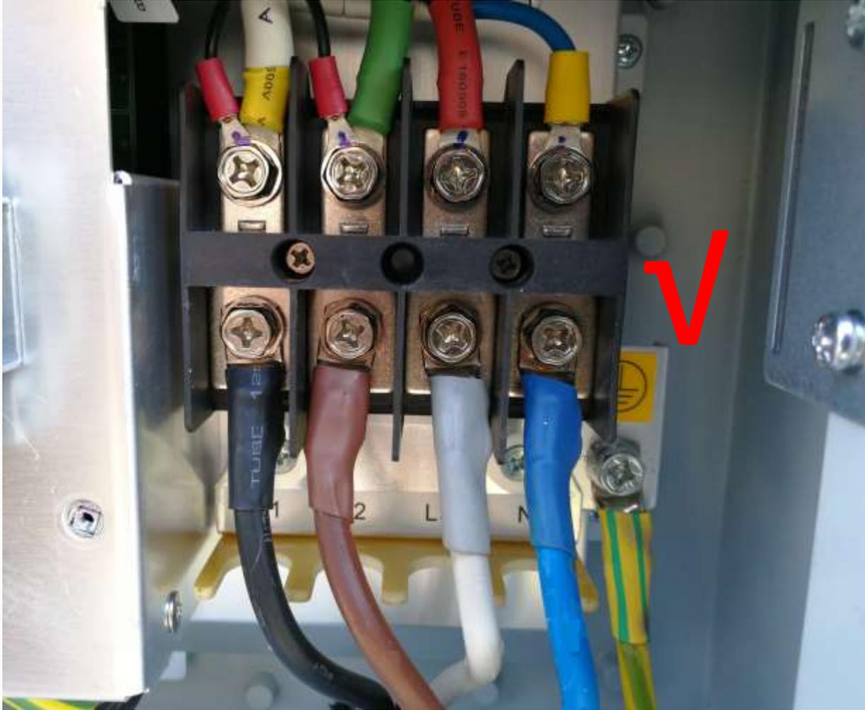
La vite è M6 e dopo il cablaggio dovrebbe serrare con la coppia di  $4\text{N} \cdot \text{m}$ .
