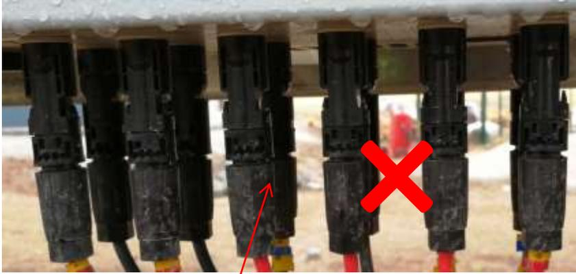
Non il connettore CC originale fornito in dotazione
