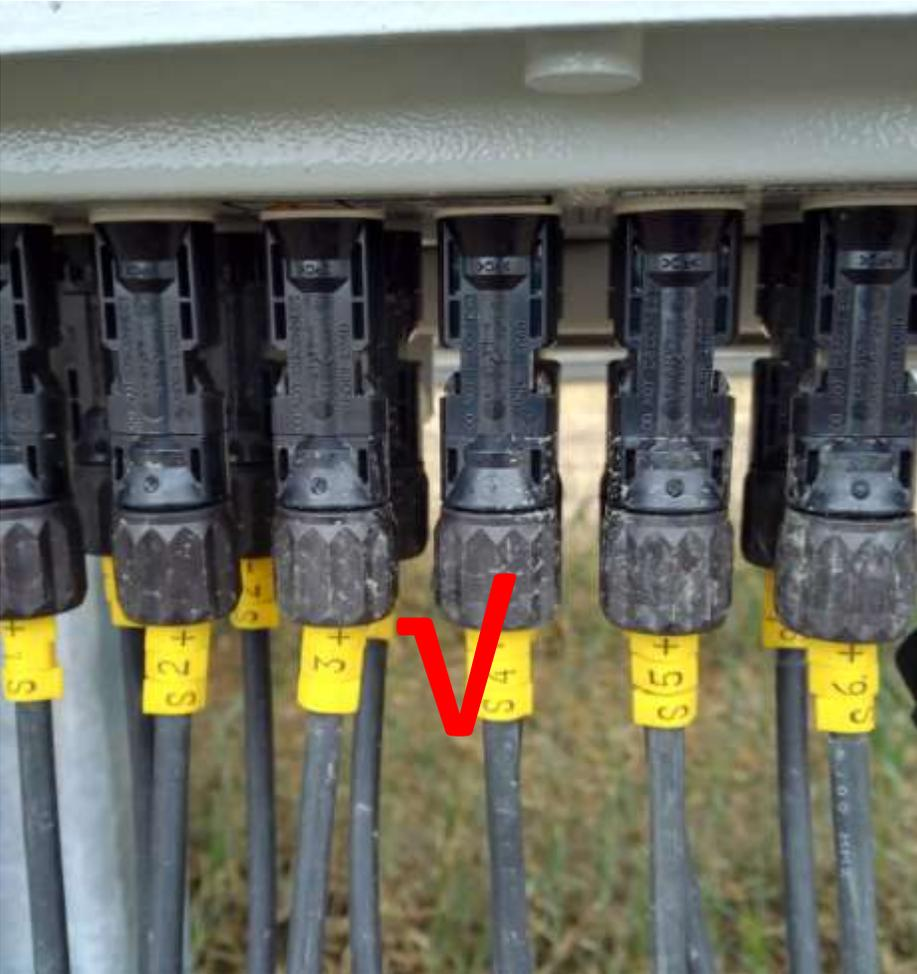
I connettori DC originali forniti con l'inverter e serrati con l'attrezzo adeguato
