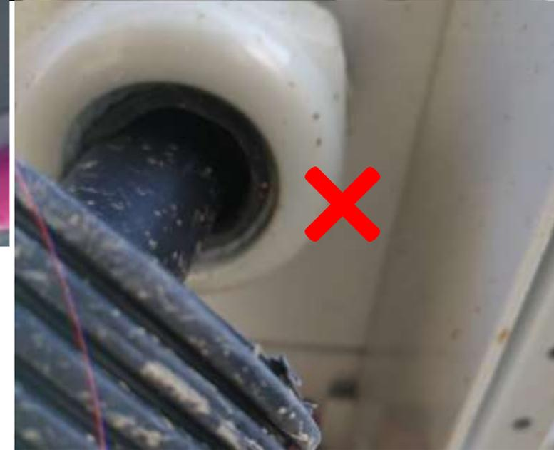
Di inverno gli insetti possono entrare all'interno dell'inverter e provocare un circuito.
